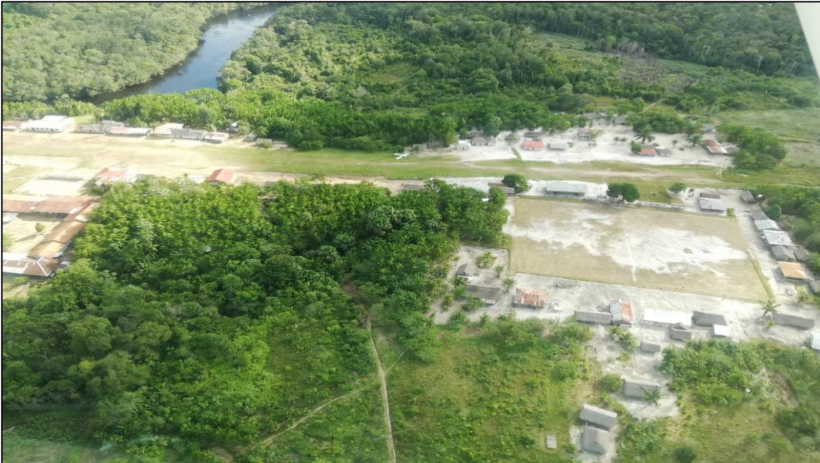
Fotografía No. 6: Condiciones de la pista poco después del evento.
